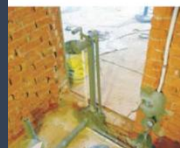
水路管路測試
